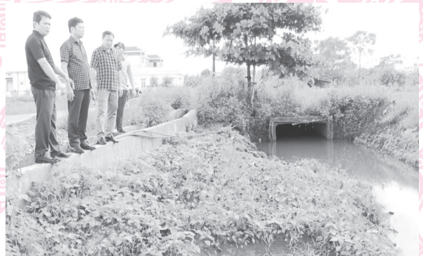
Lãnh đạo UBND thành phố kiểm tra công tác phòng, chống bão số 4 và mưa lớn tại phường Đông Lễ - Ảnh: BBT
