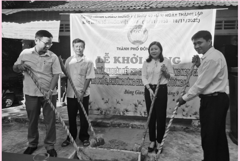
Khởi công xây dựng nhà Đại đoàn kết cho hộ nghèo ông Hoàng Ngọc Cẩm, Khu phố 2, phường Đông Giang
