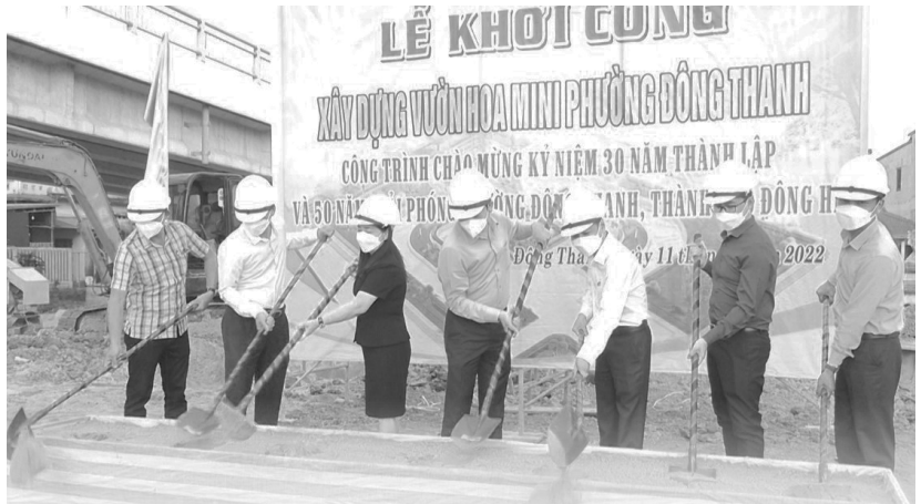
Phường Đông Thanh khởi công công trình vườn hoa mini
