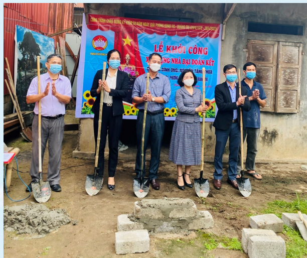
UBMT phường 1 tổ chức lễ khởi công xây dựng nhà Đại đoàn kết cho hộ cận nghèo thuộc khu phố Tây Trì
